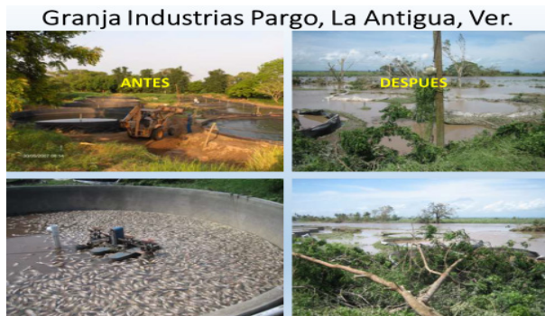
Figura 5. Granja Industrias Pargo, antes y después del huracán Karl.
