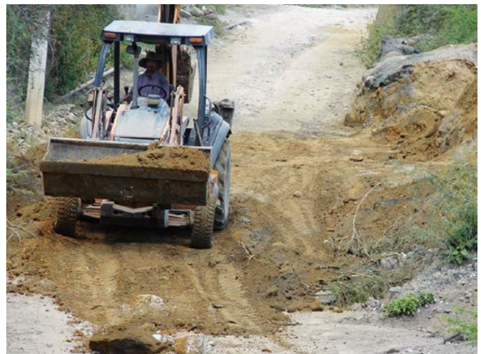
Figura 3. Residuo de mina oxidado (rico en metales tóxicos) usado para emparejar caminos. Una forma no recomendada que aumenta la exposición a contaminantes.
